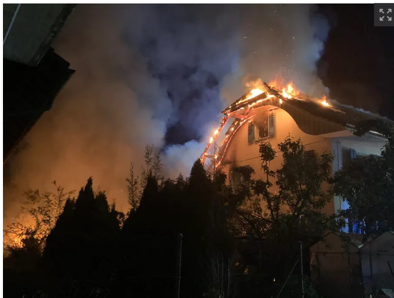
Brand im Dachstock der Liegenschaft
